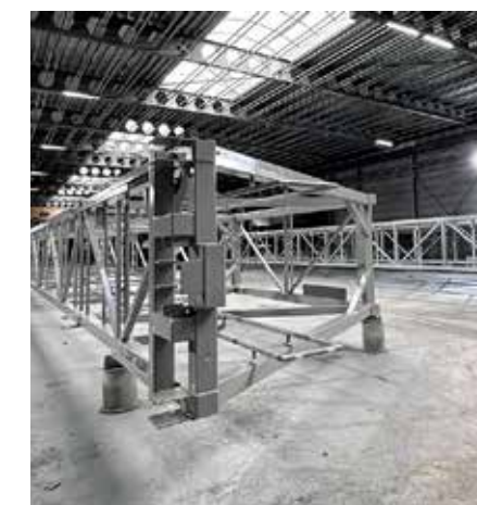
Staalconstructie in de coatinghal bij DCS.
